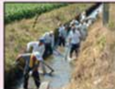
水路の泥上げ
