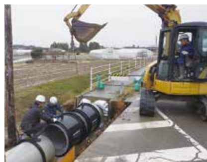
東用水路末流部災害復旧工事
