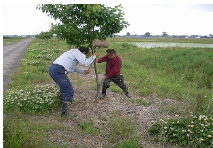
桜の木の補修作業 [維持管理活動：5月]
